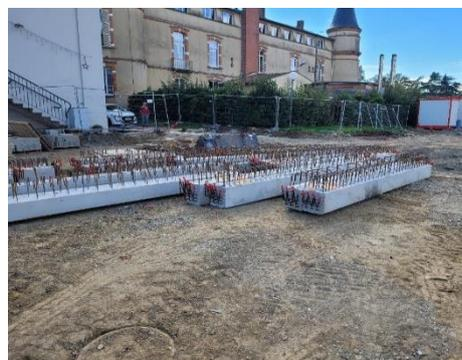
Réalisation des fondations spéciales (micropieux 10.50ml de profondeur et massifs tête de pieux)
